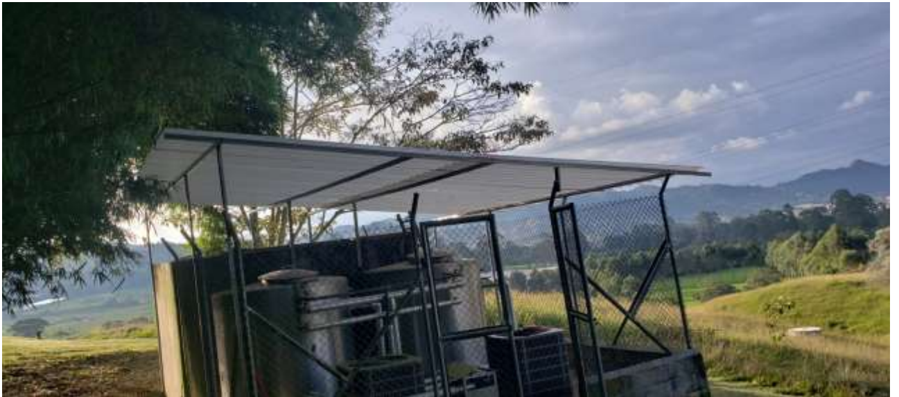
Planta de agua caliente- Instalación de techo
